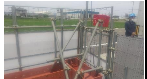
H鋼を使ったフェンスコーナー部状況
