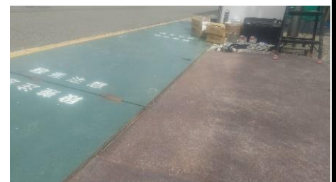
滑り止め加工鉄板状況
