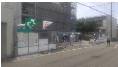
全景状況、足場・仮囲い全て山正施工現場
